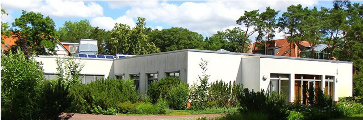
Haus 6, eine der beiden Tagesklinik im AWO Fachkrankenhaus Jerichow.
