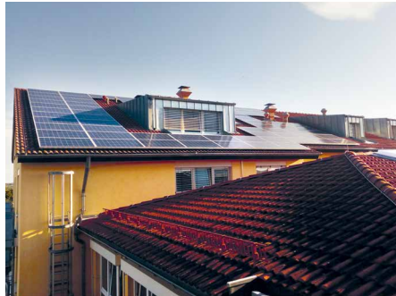
Neuerrichtung Photovoltaik-Anlage auf dem Dach der Seniorenbetreuung Neustadt, AWO Kreisverband Neustadt a. d. Aisch/Bad Windsheim e.V.
